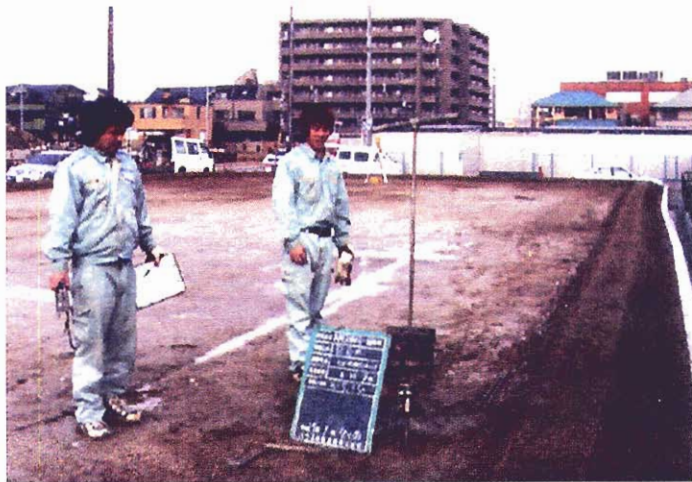
新春7日、西大寺の現地では地耐力測定と地積測量が
